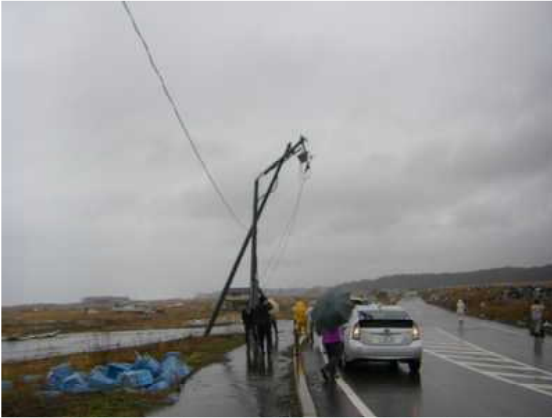
津波で折れたままの電柱
