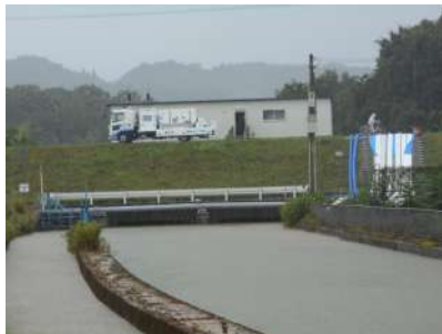
延町古川樋門前に配置された排水ポンプ車（7月7日撮影）
