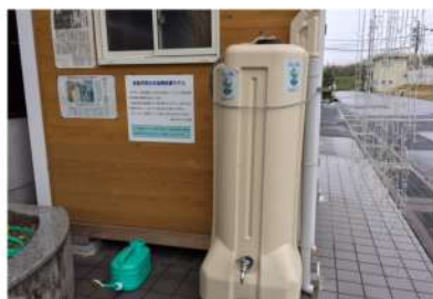
雨水貯留施設（通称マイクロ存龍）
