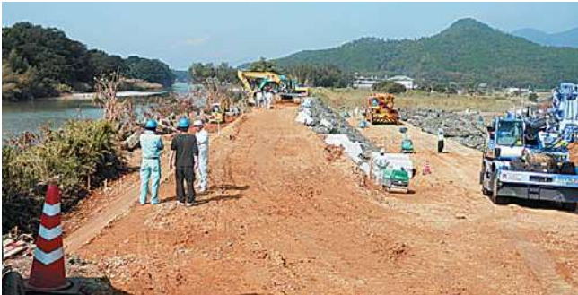
私市町の災害復旧工事(築堤工事)
