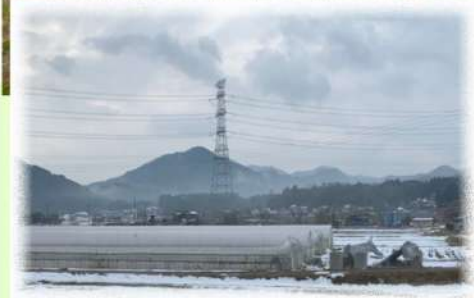
雪の重みで曲ったパイプハウス =1月11日物部地区
